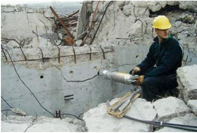
Abb. 7 Spalten durch Pressen – Keilprinzip
