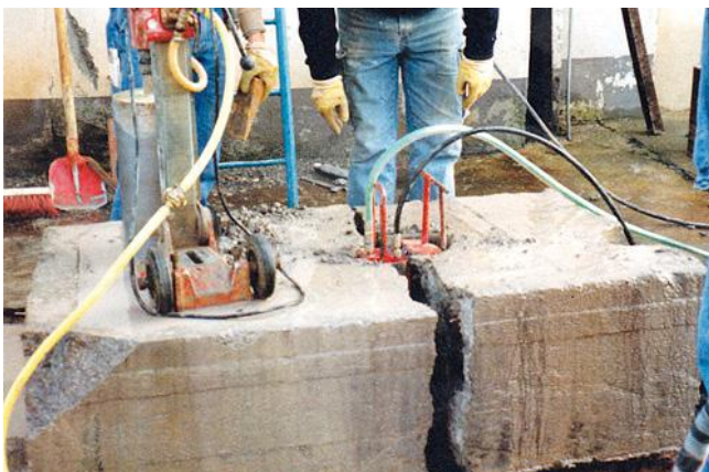
Abb. 8 Spalten mit Presszylindern
